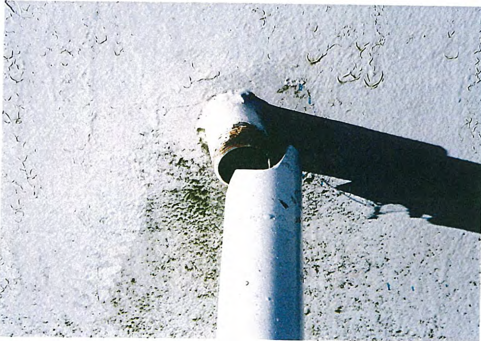
16. Broken conduit on base cone.
